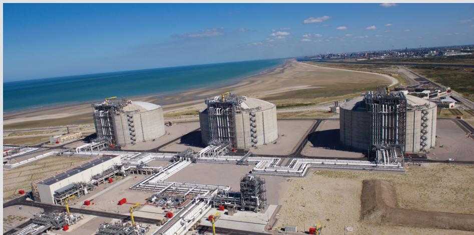
Terminal de Dunquerque (3 x 190.000m³)
